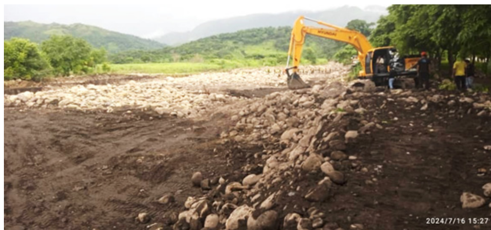
Trabajos de remoción de sedimentos en la cuenca del Manzanares
