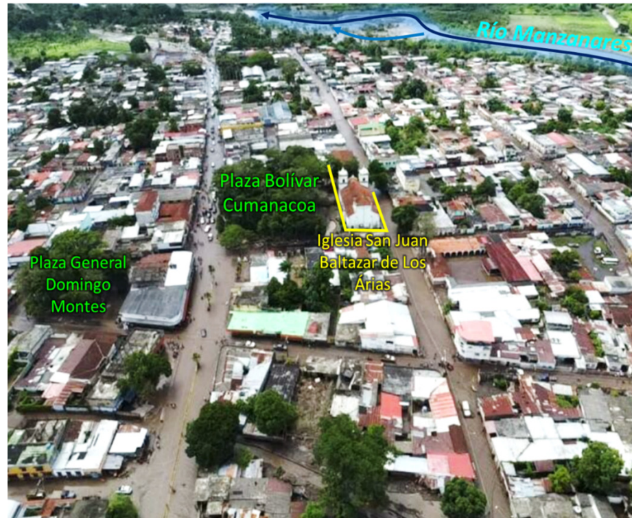
Casco urbano de Cumanacoa afectado por el desbordamiento
