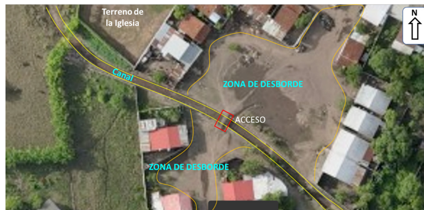
Canal de drenajes pluviales en la zona oeste de Cumanacoa
